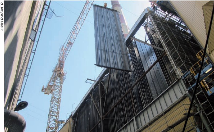
Montaż elektrody
