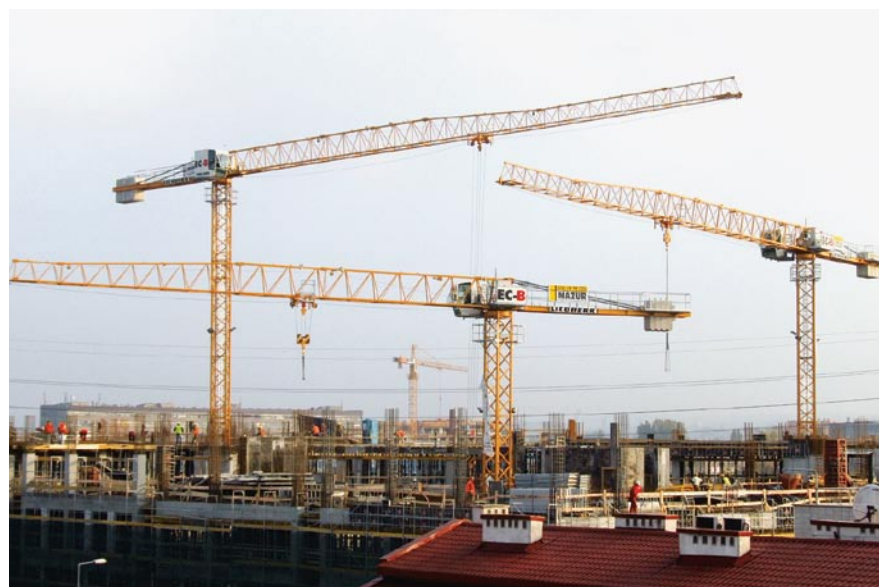
Budowa Centrum Handlowego GTC Kazimierz w Krakowie (Budus S.A.)
