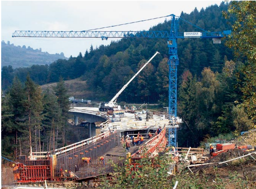
Budowa Mostu w Milówce (Skanska S.A.)
